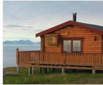
▲ Domy postawione na palach nie zapadają się w rozmarzający latem grunt.
