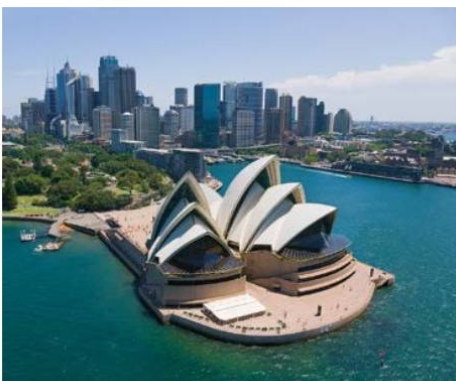
Jednym z najbardziej rozpoznawalnych budynków w Australii jest nowoczesny gmach opery w Sydney.
