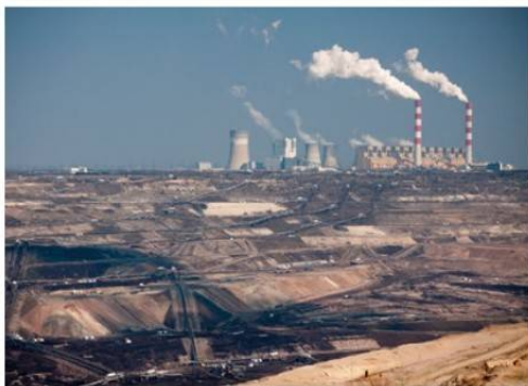
Do Elektrowni Bełchatów węgiel brunatny jest transportowany taśmociągami z sąsiadującej kopalni.
